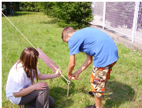
sidrenje upore antenskog stupa
